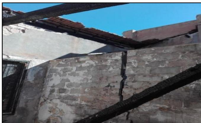
Figure 48; vue sur le parpaing de séparation (7cm)
