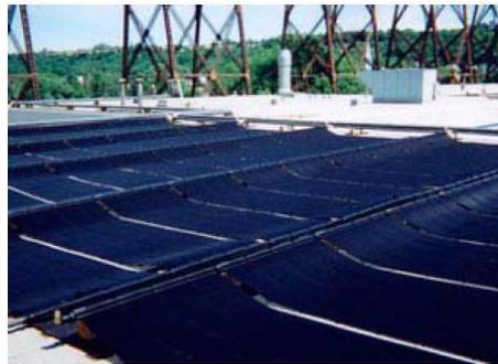
**Figure 1.3:** Capteurs non-vitrés [9]
