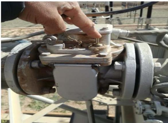
Figure III.6 : test du relai Bucholz TR
