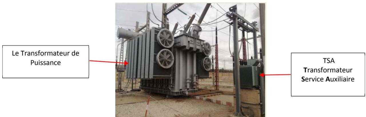
Figure I.12 : TR 220/60/11 kV 120 MVA avec TSA 11/0.4 kV 630 KVA Au Poste BISKRA.
