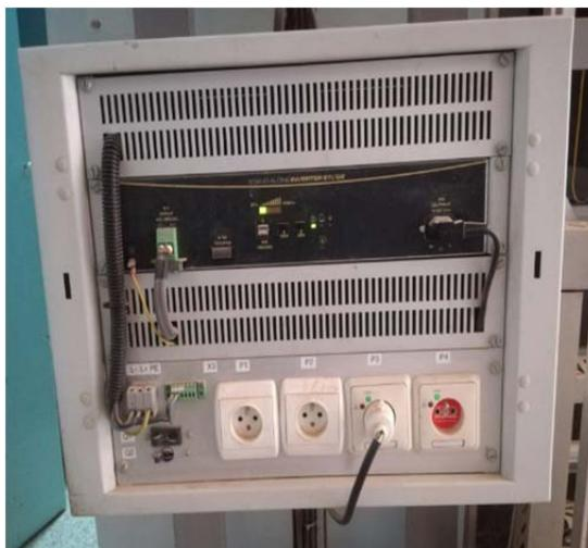
Figure I.24 : Onduleur DC/AC (127 Vcc/220 Vac)
