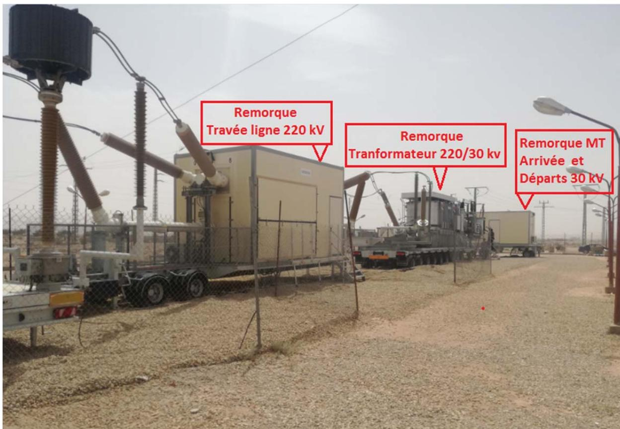
**Figure I.7** : Poste Mobile 220/30 kV (Cabine mobile) OUMACHE
