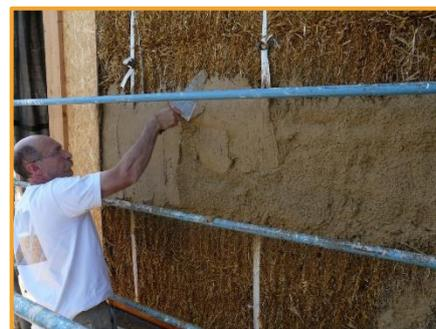
FIGURE 2.18 : La pose de l'enduit (Source : [http://www.naturel21.com/torchis\\_argile.html](http://www.naturel21.com/torchis_argile.html)).
