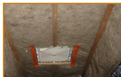
FIGURE 2.30 : Emplacement de la laine dans les gabarits. [Source :](#)
