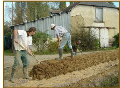
FIGURE 2.11 : Préparation de la terre de la bauge (Source: Wikipédia).
