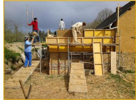
FIGURE 2.12 : préparation de la Terre de la bauge (Source: Wikipédia).
