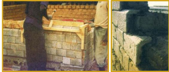
**FIGURE 2.28 :** Mur en adobéton avec des joints de collage trop épais. Source : Michel MARTEN: L'adobéton une technologie appropriée pour un habitat économe amélioré.
