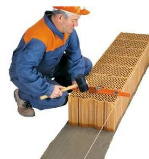
**FIGURE 2.27 :** La mise en œuvre monomur. (Source: ; www.eco-sud.com)
