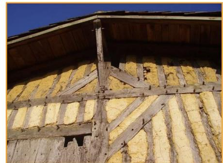
**FIGURE 2.15 :** Torchis (Source : <http://ecoconstruction.canalblog.com>).
