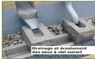
Figure 42 drainage et écoulement des eaux a ciel ouvert (Fareh.S et Aoun.N et Fekih.M, 2011)
