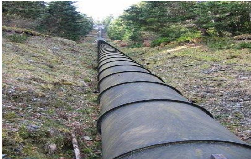
Figure 1-1- Conduite en section constante <sup>[a]</sup>
