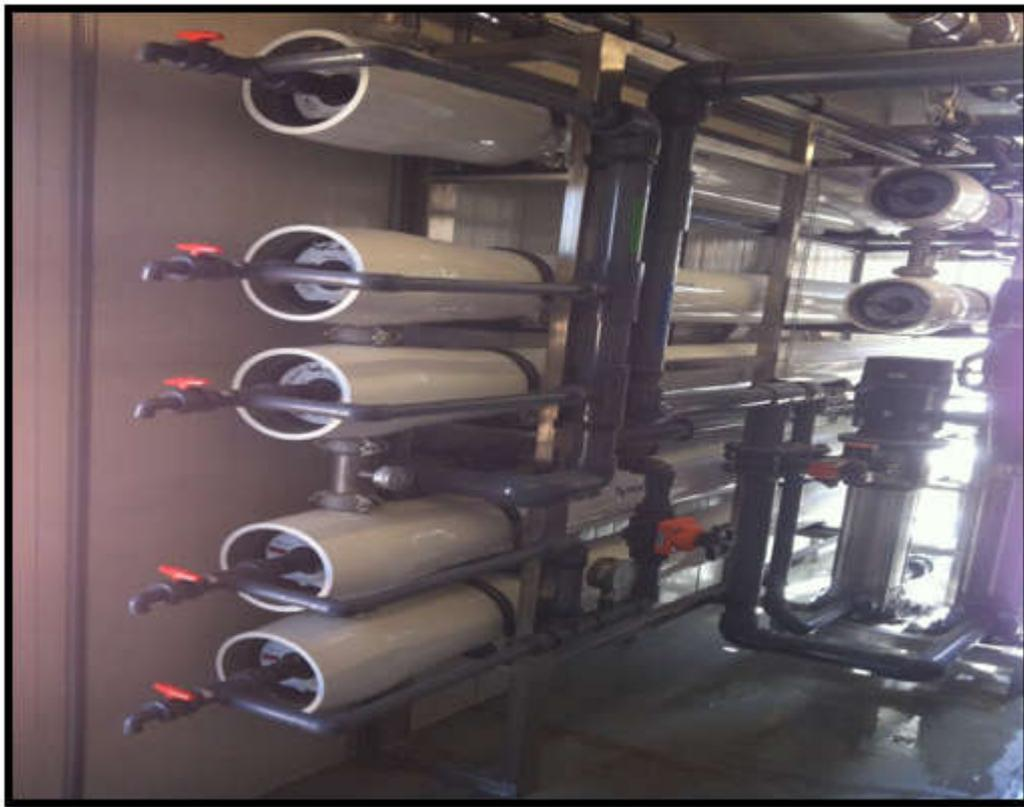
**Figure21** : Modules de l'osmose inverse au niveau de la station.
