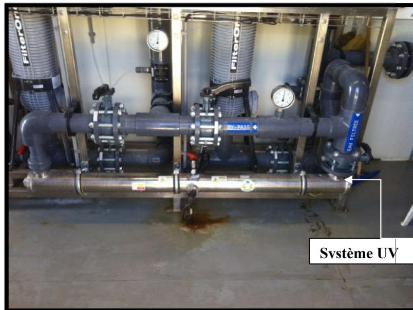
**Figure20** : Système UV au niveau de la station.
