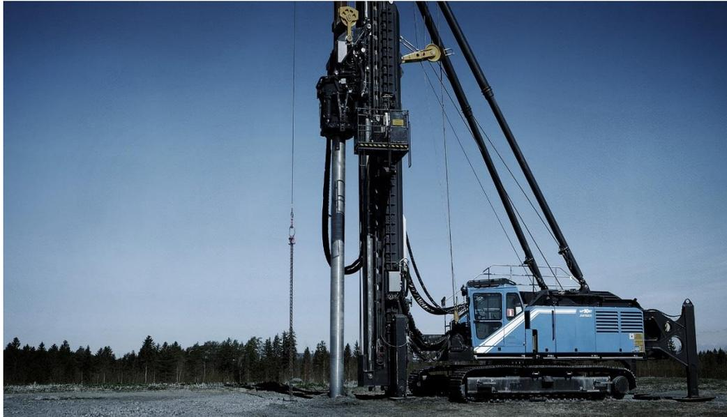
Figure 4 : Battage à tiges pleines (technique canadienne)
