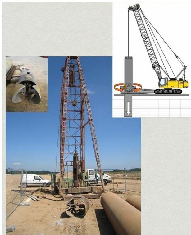
Figure 2 : Sonde de forage par Battage.
