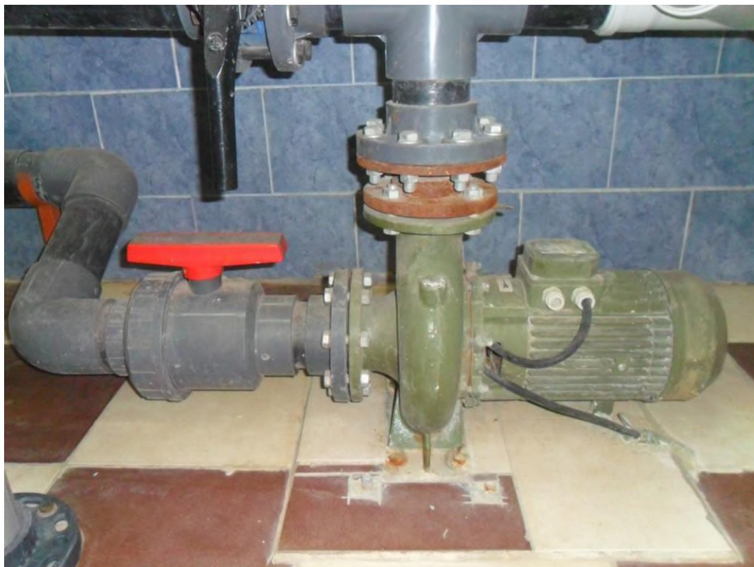
Figure 1.3 Pompe centrifuge axiale (pompe principale)
