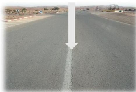
**Figure 3.80 :** Faible fissure de carrelage    **Figure 3.81 :** Fissure faible longitudinale
