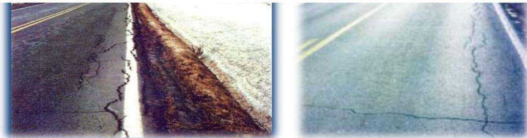
Figure 1.6 : Fissure en rive
