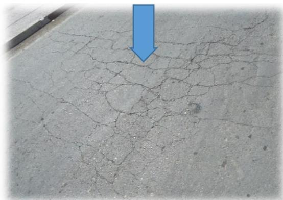
**Figure 3.11 :** Fissuration moyen de carrelage
