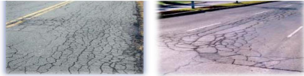
Figure 1.5 : Fissure en carrelage
