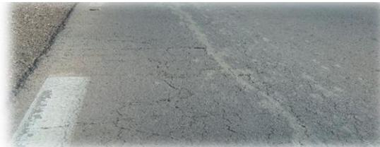
**Figure 1.8 :** Fissure d'adaptation
