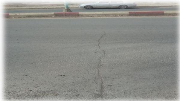
**Figure 3.112 :** Etat moyen de dédoublement    **Figure 3.113 :** Fissure transversal moyen
