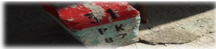
PK87 on remarque l'existence de fissure longitudinale dans la piste de roue (fissuration moyenne de 10 mm La route est large non dangereuse.
