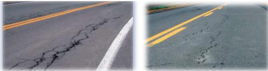
**Figure 1.3 :** Fissure en piste de roue
