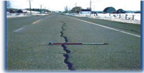
**Figure 1.4 :** Fissure longitudinal hors-piste de roues
