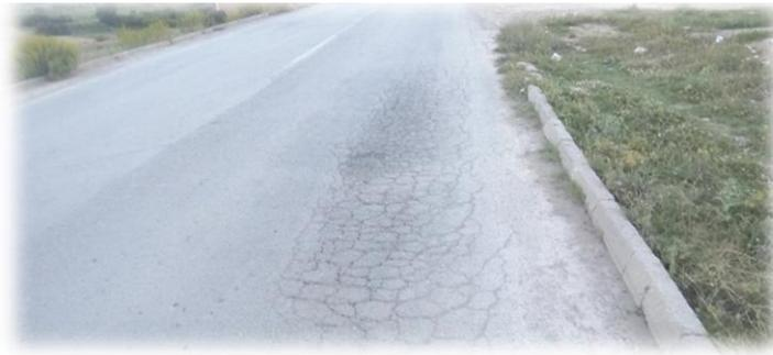
**Figure 3.3 :** Fissure moyenne de type carrelage
