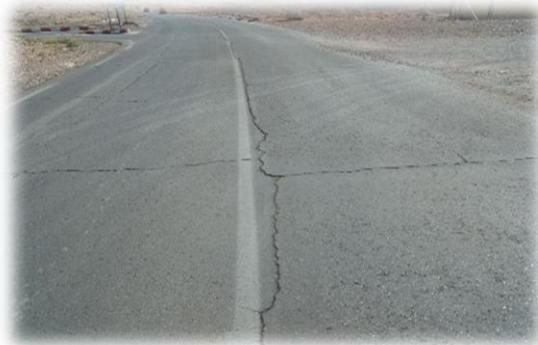
**Figure 3.83 :** Fissure en dalle
