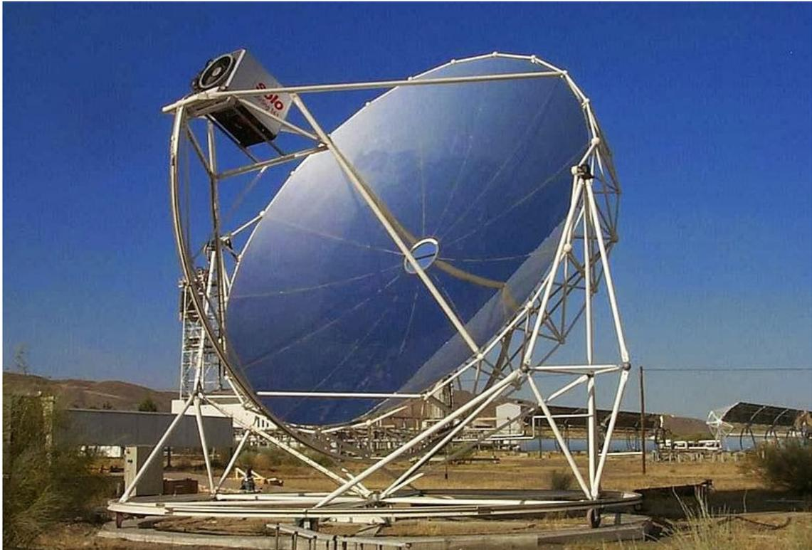
**Figure II.4 : Capteur parabolique "Dish-stirling" à Phoenix, Arizona.**
