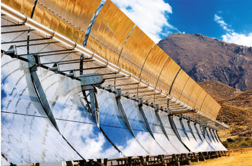
**Figure II.5: Le collecteur cylindro-parabolique.**➤ **Le réflecteur parabolique :**
