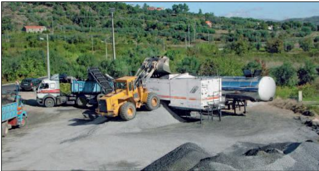
Figure III- 5 : malaxage en centrale (16)
