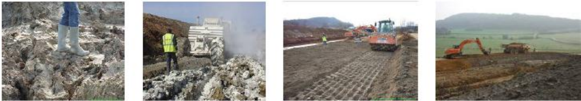
Figure I- 11: Chantier expérimental de Héricourt (70) avec l'utilisation des argiles A3/A4 traitées en remblai, avant traitement ; malaxage ; compactage en remblai ; vue finale
