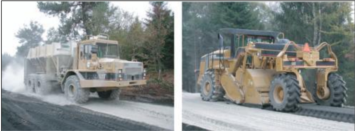
Figure III- 6 : Epandeuse/ tombereau articulé à gauche et pulvi-mixeur à droite
