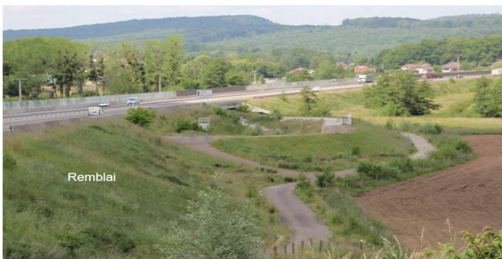
Figure I- 12: Vue du remblai expérimental (mai 2015) cinq ans après sa construction
