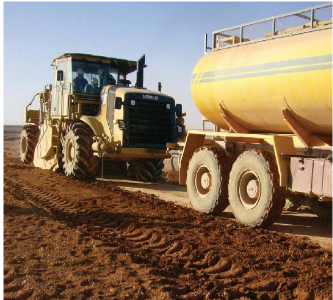
Figure I- 8: Epandage et le malaxage
