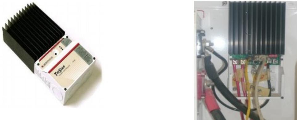
**Figure 3.5 Régulateur de charge TRISTAR**
