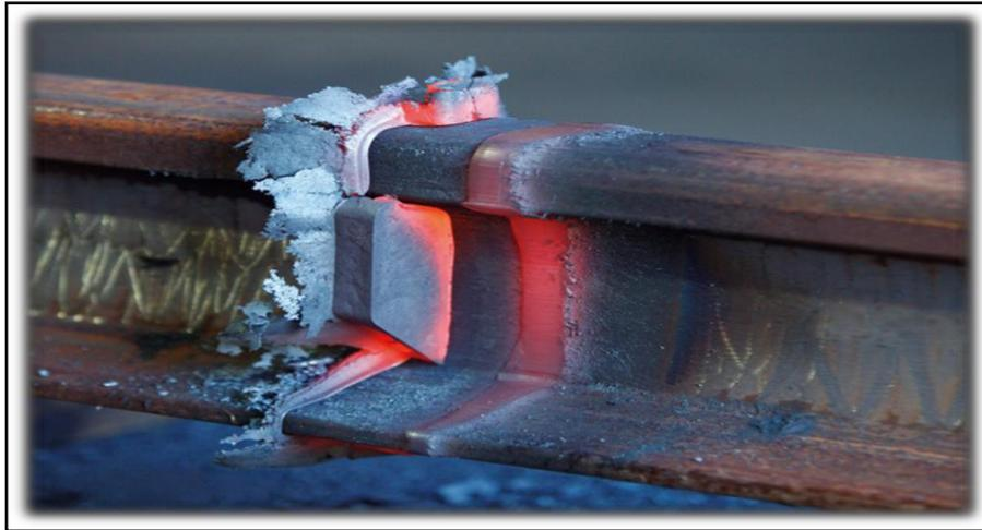
**Photo n°01 : soudure de LRS**
