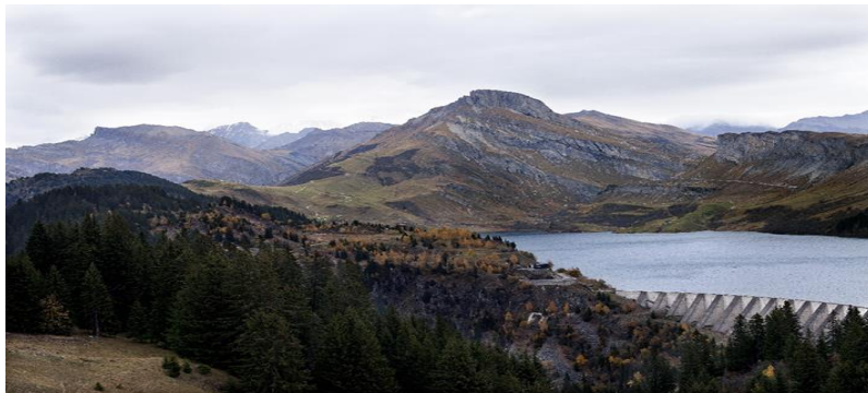
Figure I.3 : centrales au fil de l'eau
