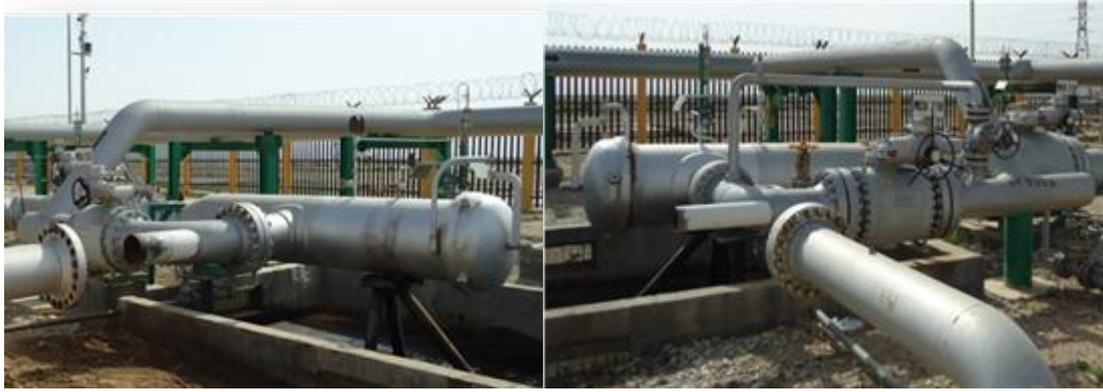
Figure III.4 : Gare racleur d'entre et de sortie à site
