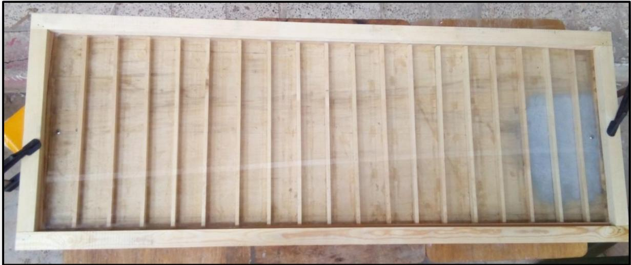
Figure (II.7) : Nervures alignées en rangées
